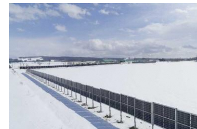
垂直設置型太陽光発電設備
