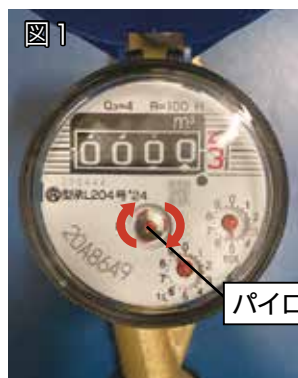
図1 地下式水道メーター
