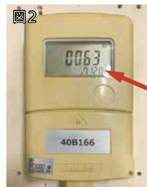
図2 地上式水道メーター
