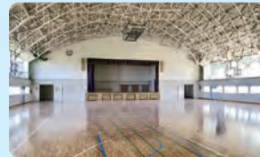
体育館の内部（施工前）
