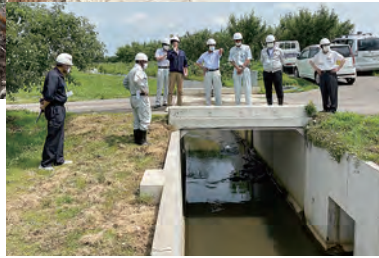
施工後の現場説明を受ける(葛野)
