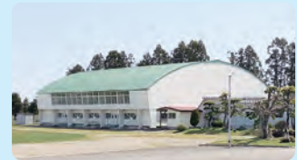
体育館の外観
